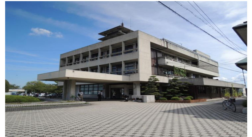
當麻メディアセンター（當麻庁舎外観）
