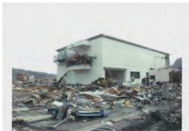
NTT東日本の交換局被災状況 (岩手県大槌町)
