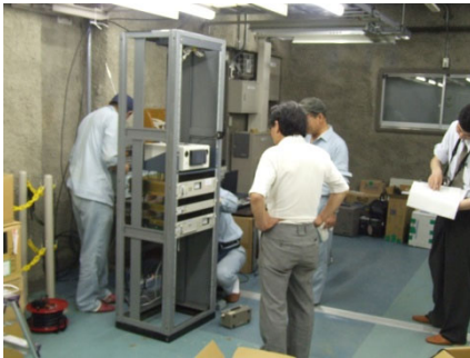
道路情報(VICS)取付工事 (小木ノ城中継局)
