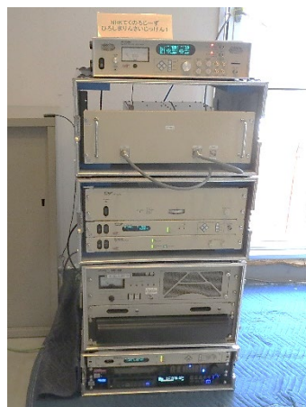
(無線装置設置状況)
