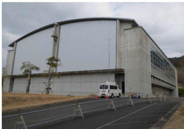
(電波測定車 設置状況)
