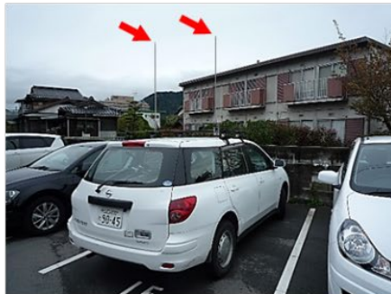
アンテナ設置状況
