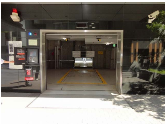
有人機械式駐車場
