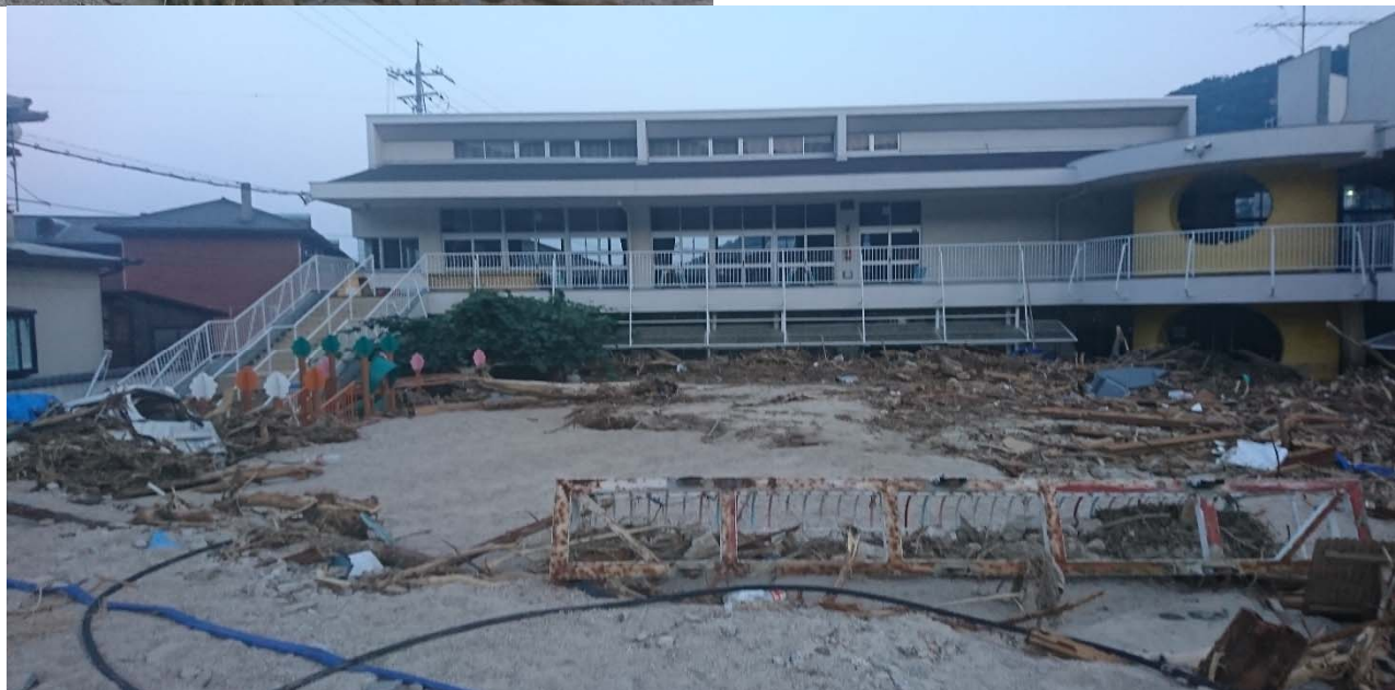
土砂や流木が流入 ▶ (小屋浦みみよう保育園)
