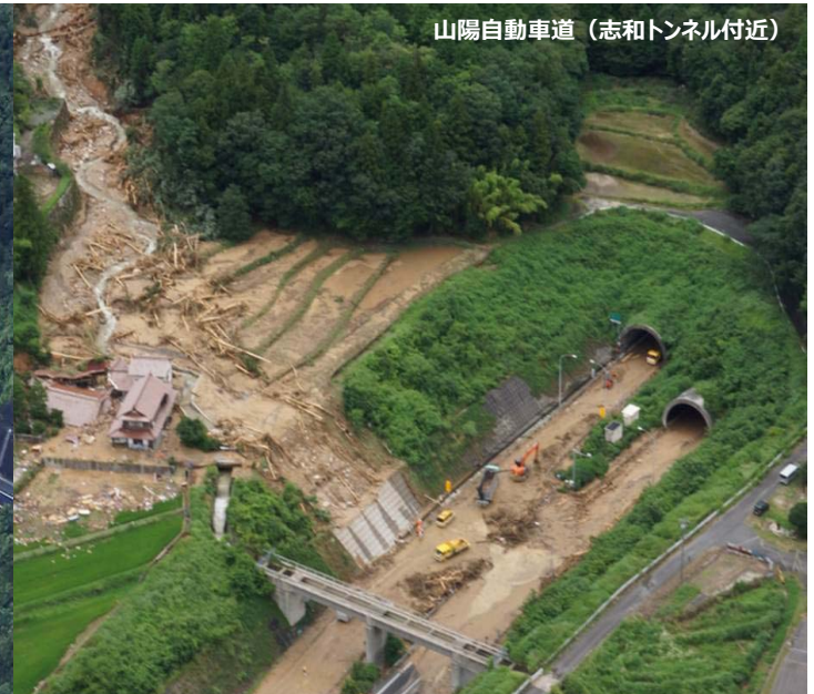
広島呉道路（安芸郡坂町水尻）
